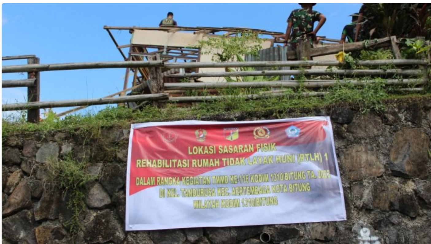
Kegiatan Pembangunan Rumah Tidak Layak Huni (RTLH) oleh Satgas TMMD Ke-116 di Kelurahan Tandurusa
