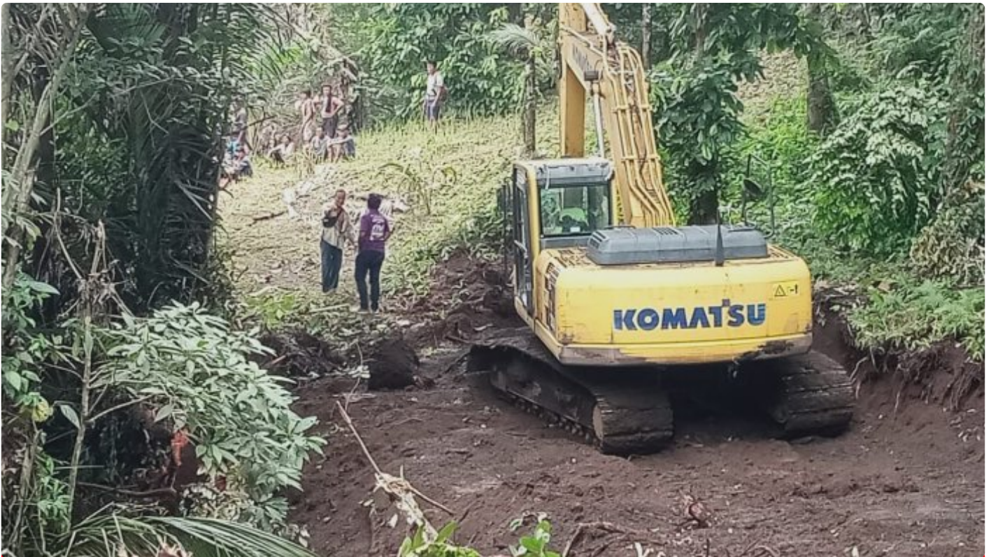
LokasibPekerjaan Perintisan Jalan TMMD Ke-116 Kodim 1310 Bitung di Kelurahan Tandurusa
